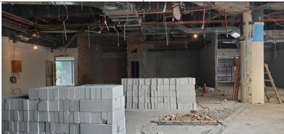
项目三层现状照片
