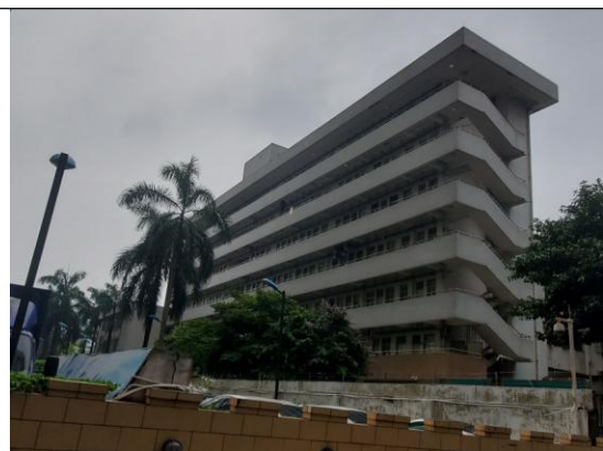
项目西侧广州体育学院宿舍楼
